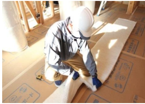
② 採寸した寸法より200~250mm長めにカットします。 (※) (折しろ部分を作る)
