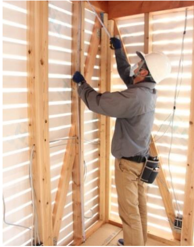
① 充填する箇所を採寸します。
