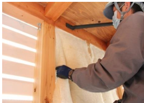
⑥ しわと隙間ができないよう注意しながら充填していきます。
