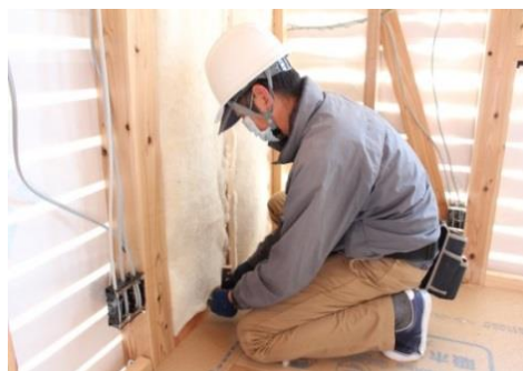
⑨ 折り込んだ部分をタッカーで固定して完了です。
