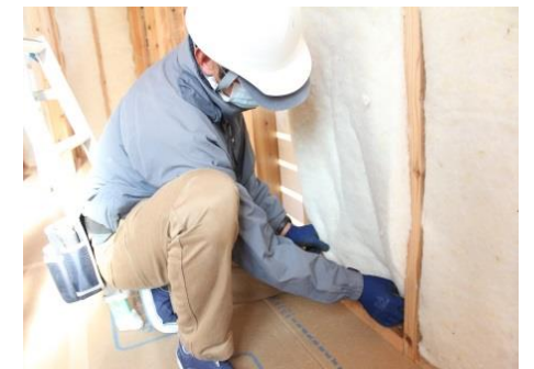
⑧ 下部 折しろ部分を折り込むように納めます。
