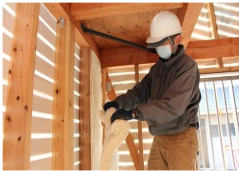
③ ウールブレスの上端を折り曲げます。
