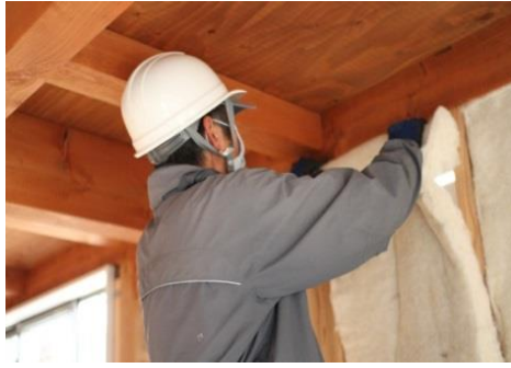
④ 折り曲げた状態のまま上部に押し当てて充填します。
